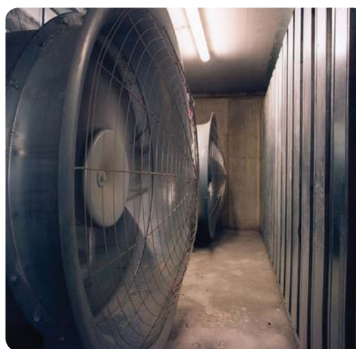
Вентиляторы дымоудаления с шумоглушителем на входе
