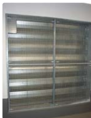
Внутренние решётки забора / подачи воздуха
