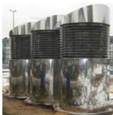
Наружные конструкции забора / выброса воздуха
